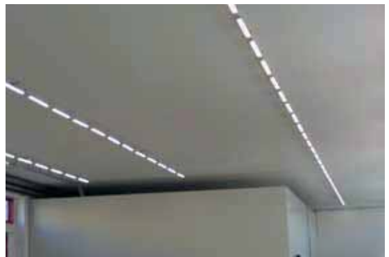
GARAGE PALAZZINA DEL SOLE | Asti
