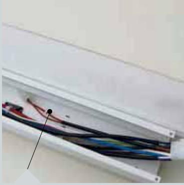
Ligne passante 7 x 1,5 mm 2 et broche de sélection de phase. Particular línea pasante 7x1,5 mm 2 y pin de elección de fase.
